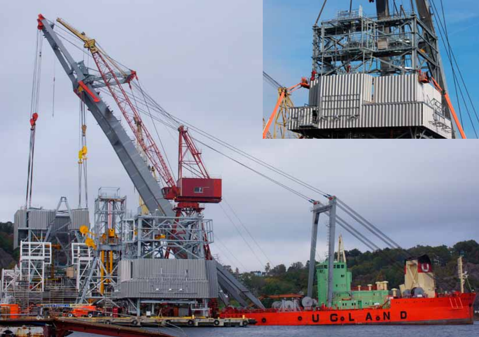
Med presisjon og stø styring løftes deler av "derrick" på plass på boredekket ved hjelp av HLV Uglen. /With steady course and precision derrick sections are lifted in place onto the drilling deck by HLV Uglen.
