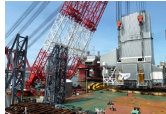
Her henger nederste delen av modulen i krana, klar for landing på selve riggen. Here the lowest part of the module is hanging in the crane, ready to be placed on the rig itself:
