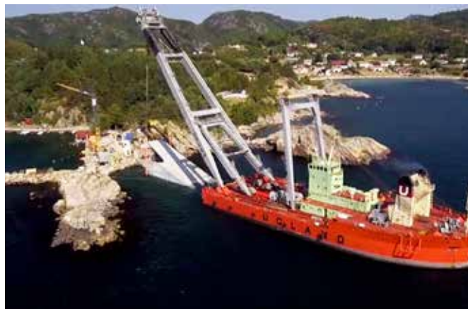
HLV Uglen løfter "Under" på plass/ HLV Uglen lifting "Under" in place
