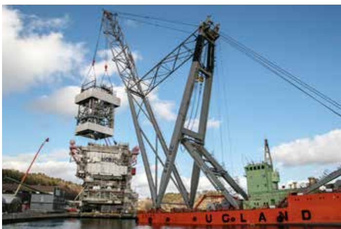
Over: Heller ikke noe å si på kompleksiteten under en boremodul. I tillegg til selve stålråmmene skal det være plass til alt av utstyr, rør, kabelgater, etc. uten at noe kolliderer.
