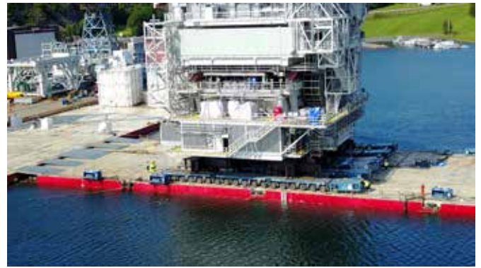
Over: Ferdig boremodul kjøres ut på "Boabarge 43" med Sarens SPMT's (108 axles)
