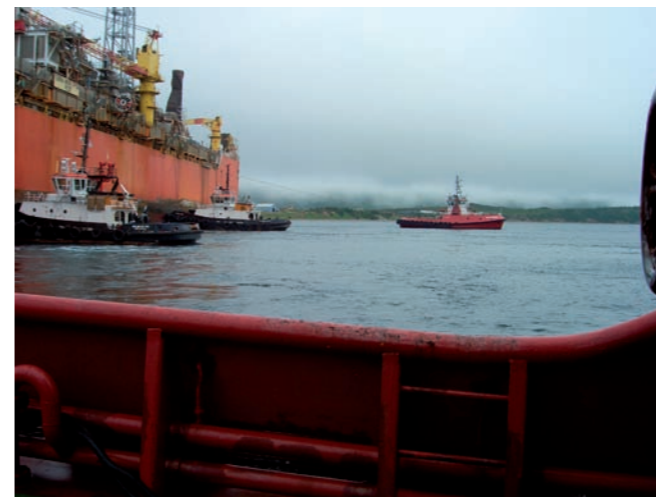
Placentia Hope i posisjon for dokking av Terra Nova FPSO plattformen/ Placentia Hope in position for docking of the Terra Nova FPSO.
